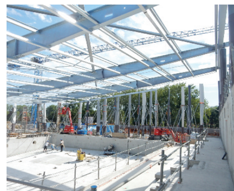
Ici, les rupteurs Isokorb KST se situent dans le plan du mur rideau. Et comme pour Saint-Fulgent, il n'y a pas de bras de levier à reprendre du fait des poteaux structuraux qui soutiennent les 3 toitures.
