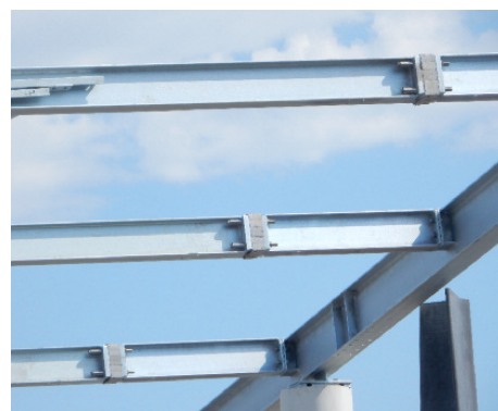
Ici, les rupteurs Isokorb KST se situent dans le plan du mur rideau. Et comme pour Saint-Fulgent, il n'y a pas de bras de levier à reprendre du fait des poteaux structuraux qui soutiennent les 3 toitures.
